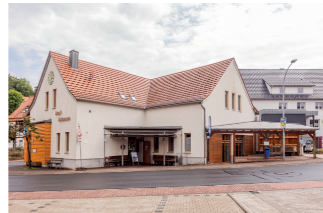
Abbildung 6: Dorfscheune Pfaffenhausen, © Dennis Möbus
