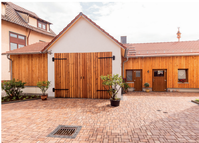
Abbildung 12: Backhaus Außenansicht, © Dennis Möbus
